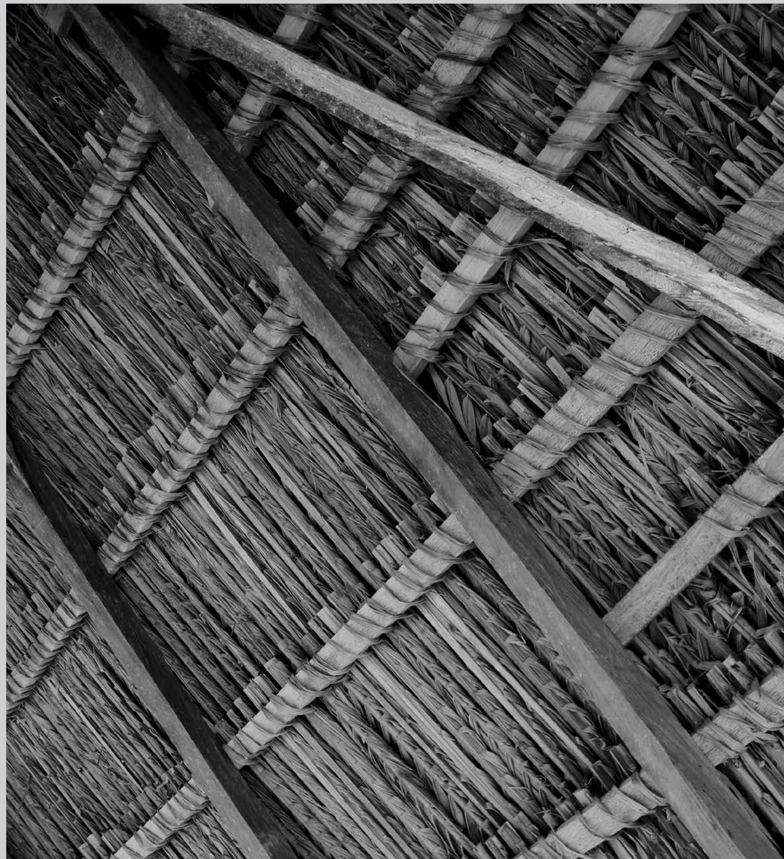
Techo en palma de corozo vertical. Vereda Pasifueres, Municipio de San Benito Abad, Sucre.
