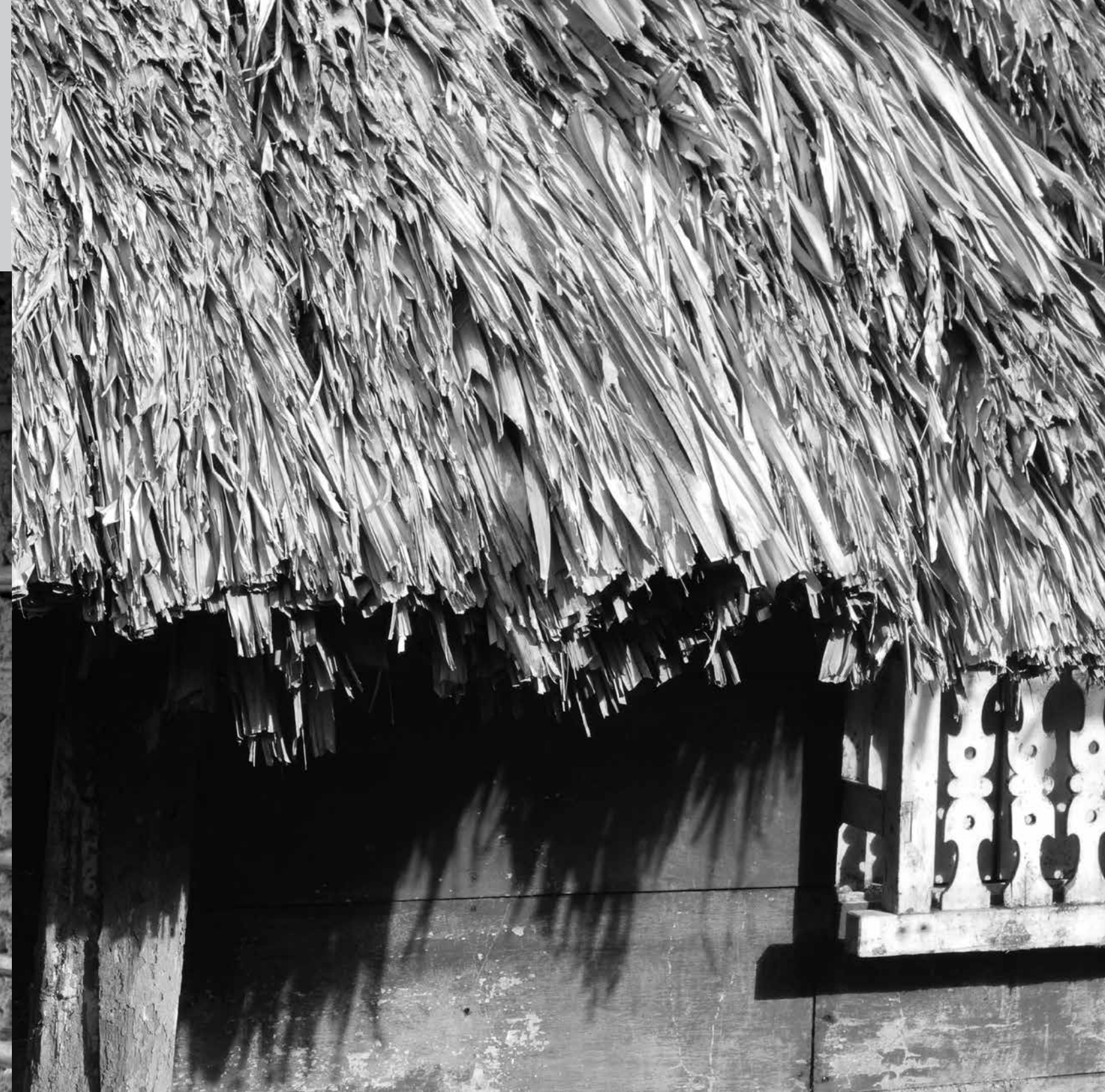
Casa ancestral con muros y carpintería de madera y techo de palma amarga. Corregimiento de Nariño, Municipio de Lorica, Córdoba.
