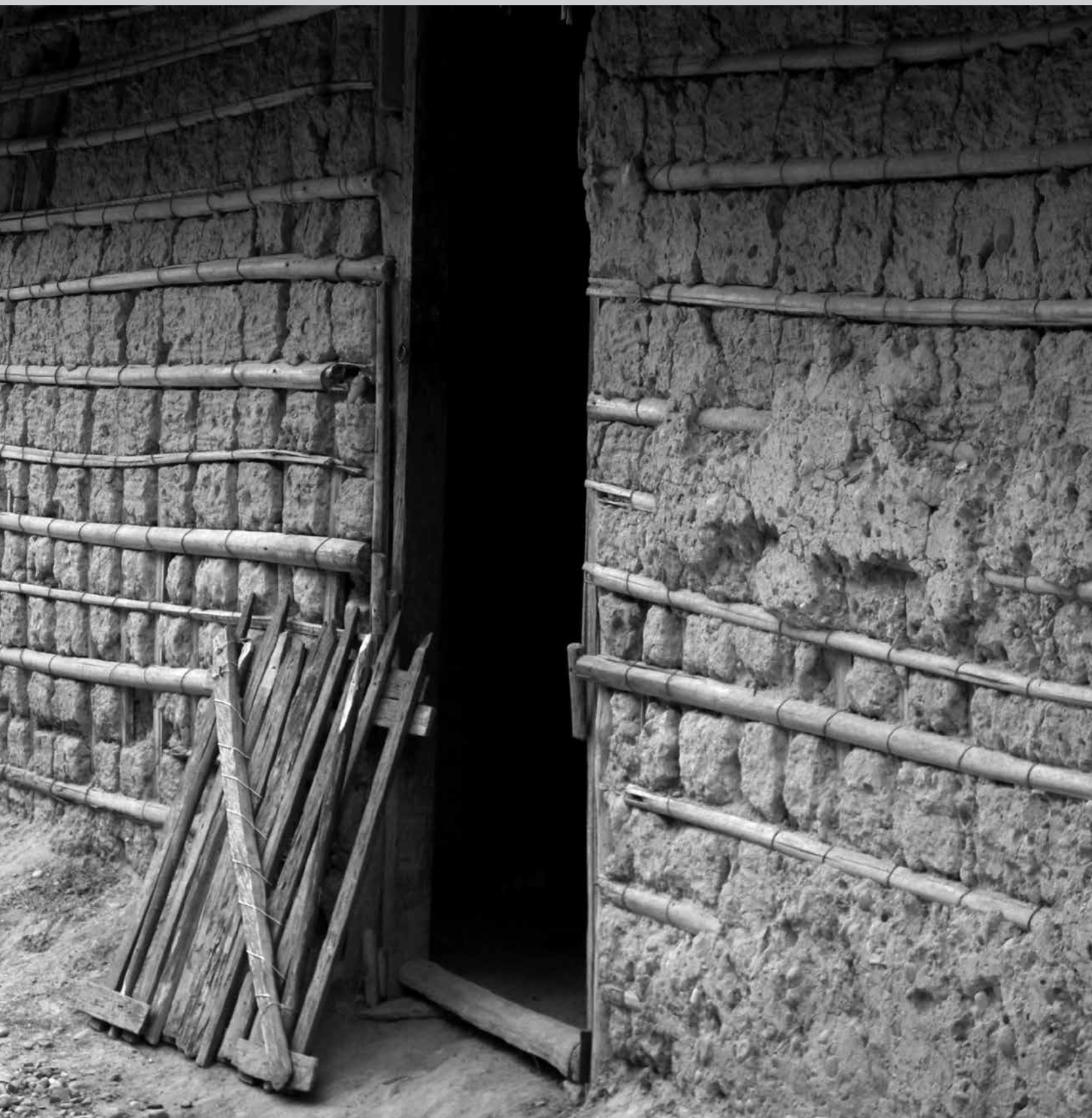
Casa de bahareque con rejilla en cañabrava. Vereda Antequera, Municipio de Tamalameque, Cesar.
