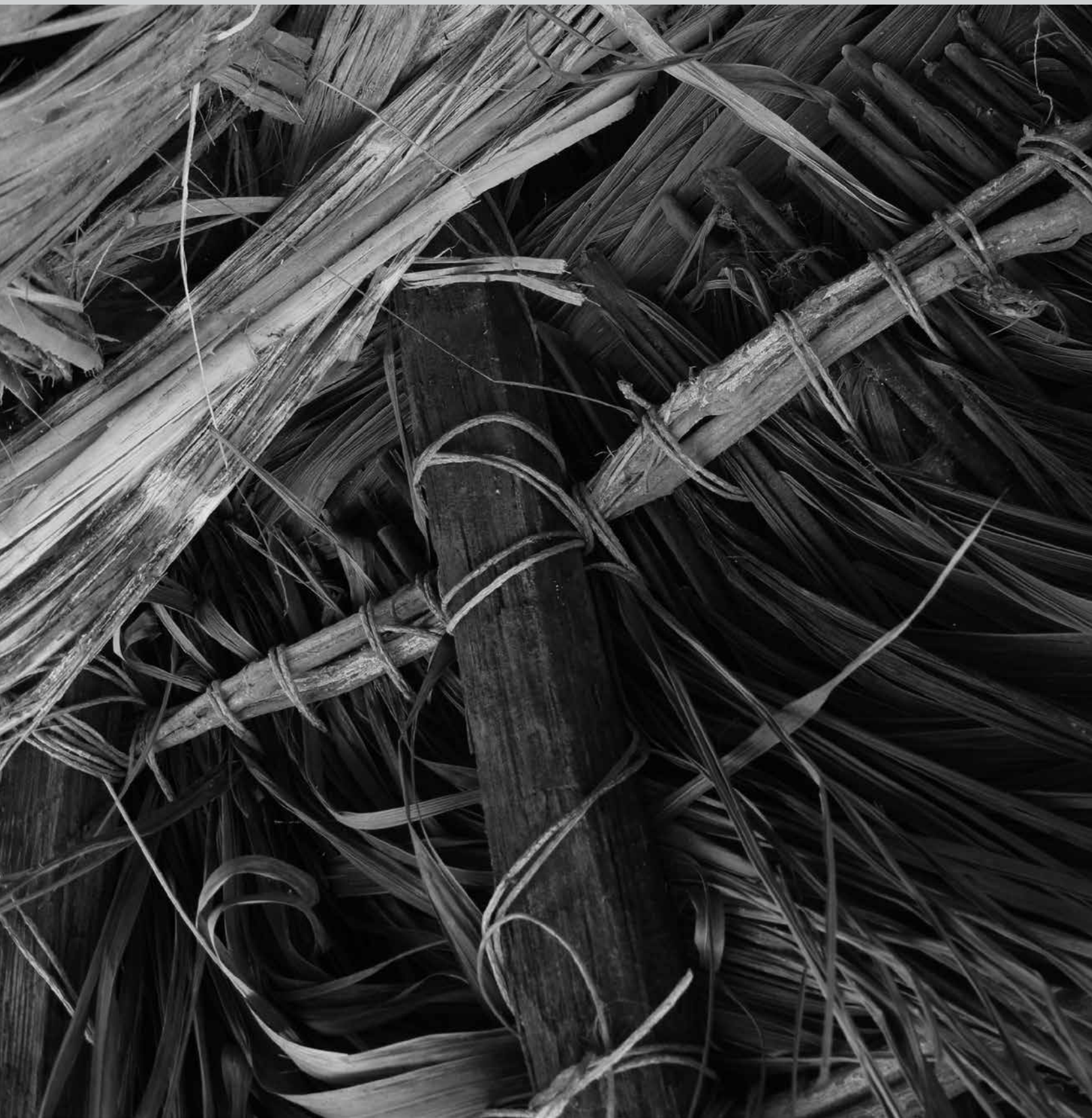
Cobertizo provisional con estructura de cocotero, envarado en madera de matarotón y cerramiento en palma iraca y palma amarga. Corregimiento de Palomino, Municipio de Dibulla, Guajira.
