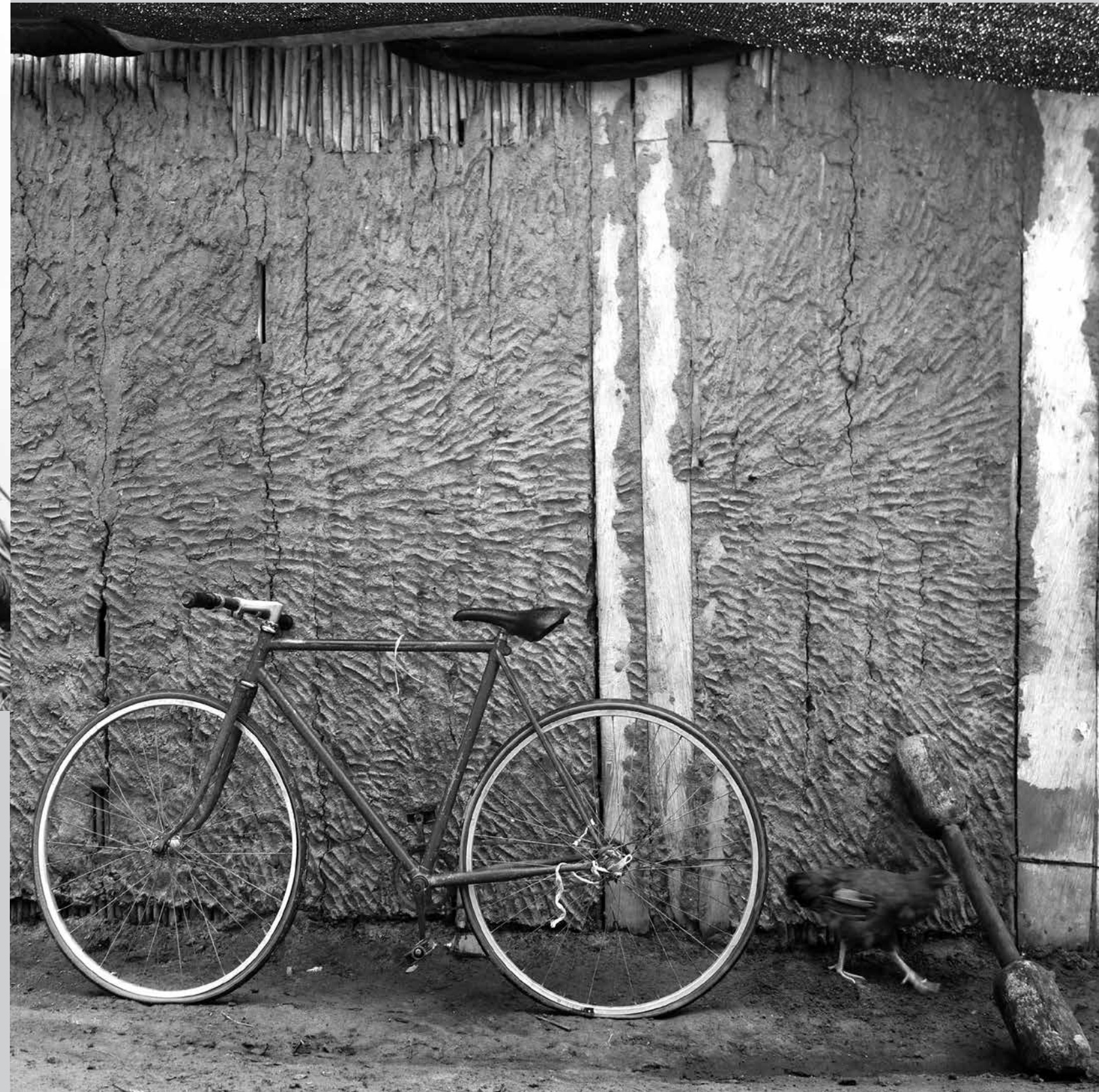
Casa de bambú con repello en tierra. Cabildo de San Martín, Sucre.
