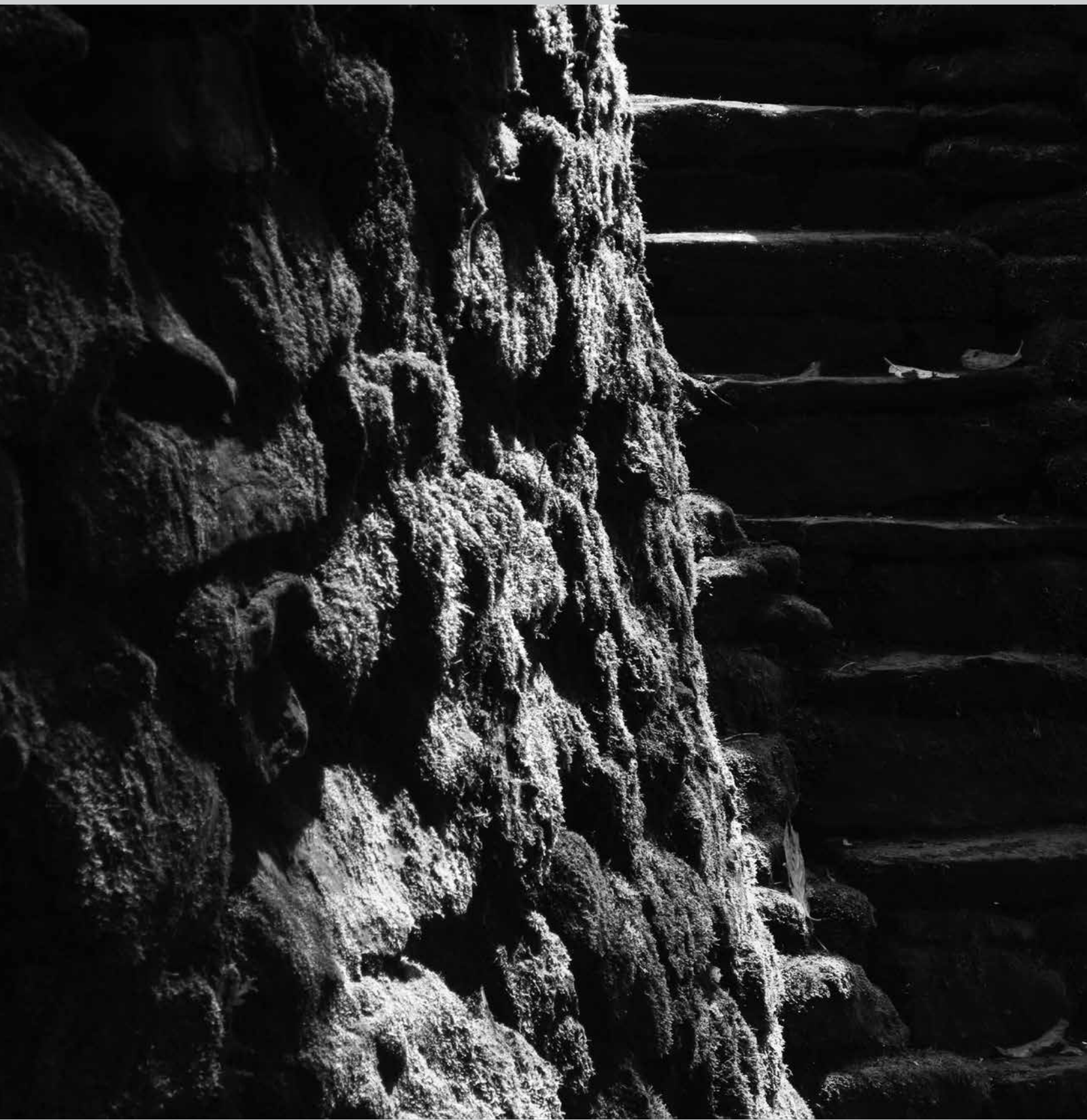
Muro de contención y escalera en piedra sin mortero. Teyuna (Ciudad Perdida), Magdalena.
