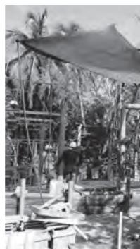
Figura 15. AC. Proceso constructivo del centro comunitario El Morrocoy, en la vereda El Torno. Cimentación sobre aterrado, uso de madera de reforestación, materiales y técnicas vernáculas de La Mojana, Sucre y Córdoba. Abril de 2017. Fuente: archivo de los autores.
